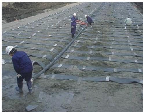
写真-2 水平ドレーンの敷設状況
