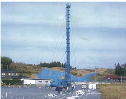
写真-1 鉛直ドレーンの打設
