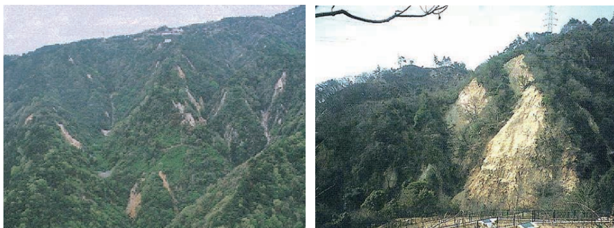
兵庫県南部地震による山腹崩壊（兵庫県提供）
