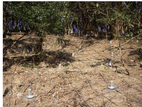
愛知県南知多郡南知多市（施工直後）
