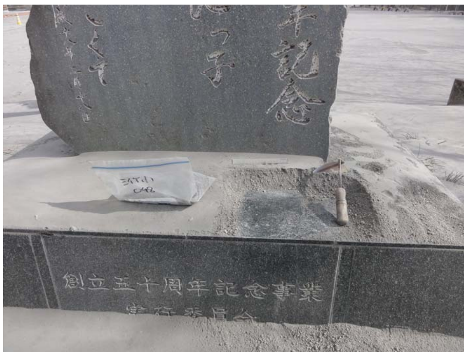
写真-9 宮崎県都城市御池の御池小学校（新燃岳火口から約8km） （堆積物の厚さは5cm程度、写真には写っていないが3-5cm程度の軽石も確認）
