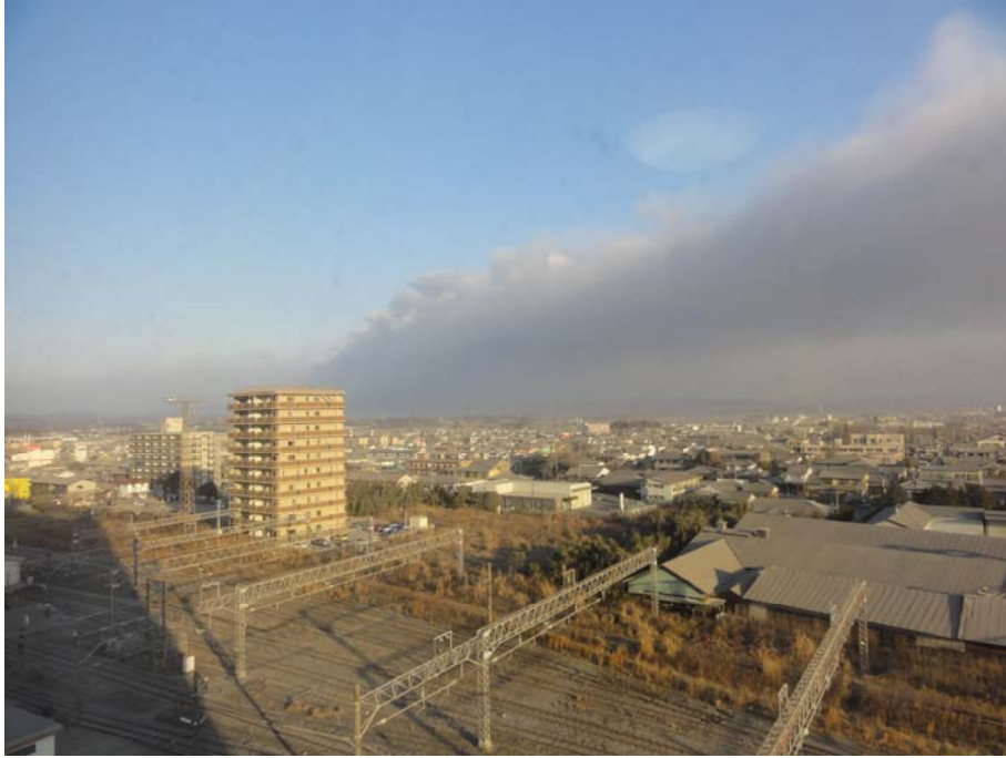
写真-1 宮崎県都城市街地（新燃岳火口から約 27km） （新燃岳からの噴煙が到達し，市街地中心部は 1cm 程度堆積）
