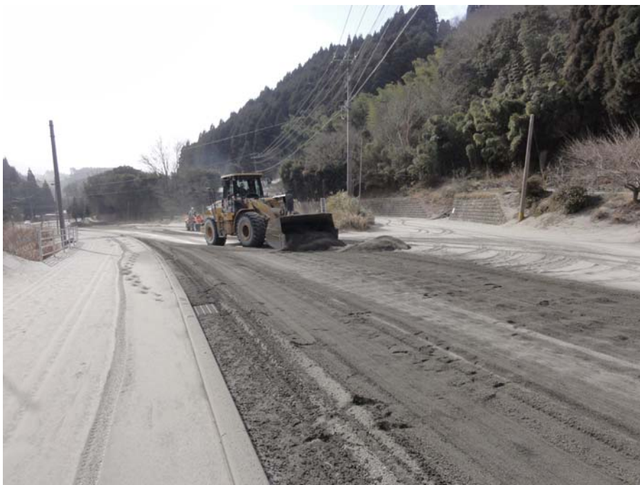
写真-7 宮崎県都城市夏尾町牛の臈（新燃岳火口から約 10km） （片側交互通行規制を実施しながら堆積した軽石を除去中）
