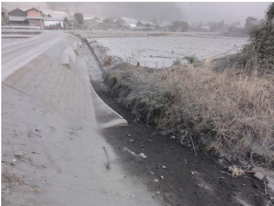
写真-6 宮崎県都城市夏尾山田城ヶ尾（新燃岳火口から約 15km） （溪床・田畑一面に降灰）
