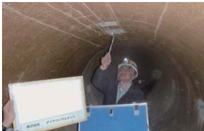
管頂部における測定状況
