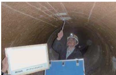
管頂部における測定状況
