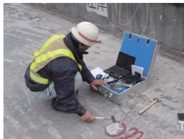
ダムの健全度調査・診断事例
