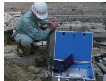
杭の健全度調査・診断事例
