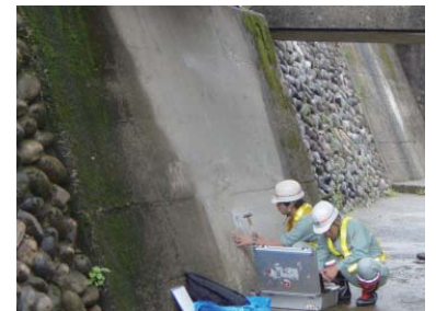
橋台の形状寸法調査事例
