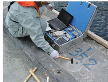
護岸鋼矢板の設置深度調査事例
