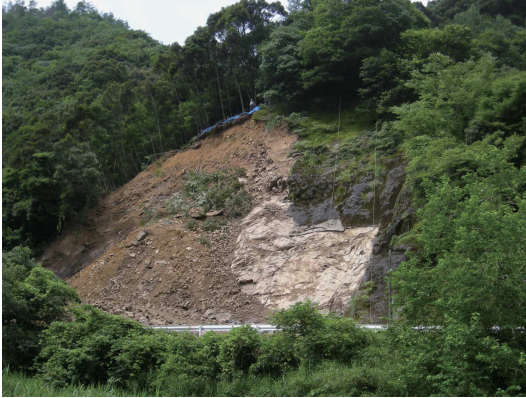
崩壊現場全景
