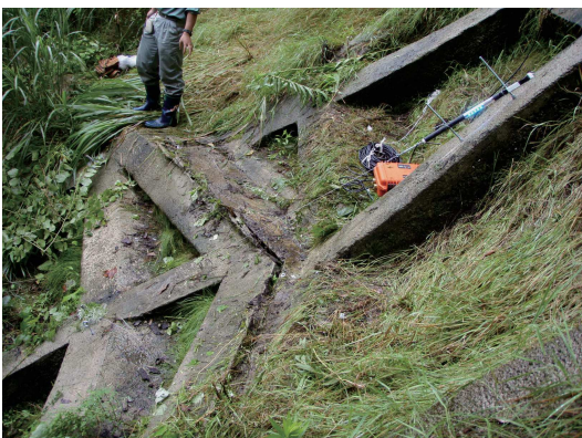
光る変位計設置
