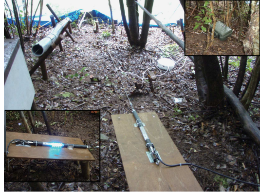
光る変位計設置
