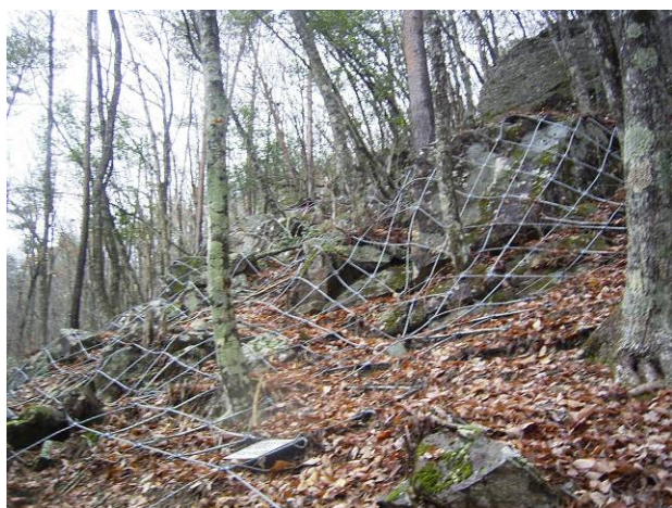
図2 ロープネット工の施工例
